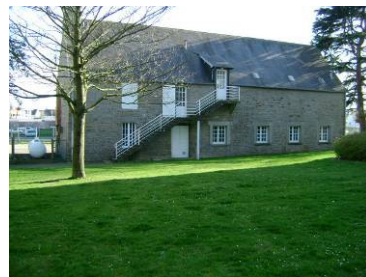
Ferme Trublet vue arrière
